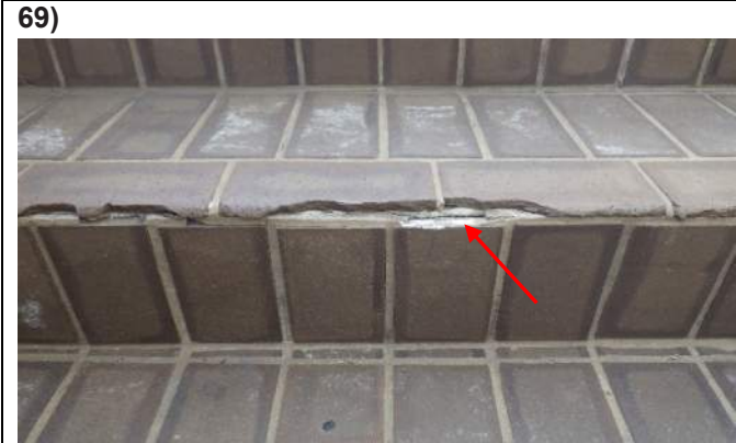
OPC exterior stairs
