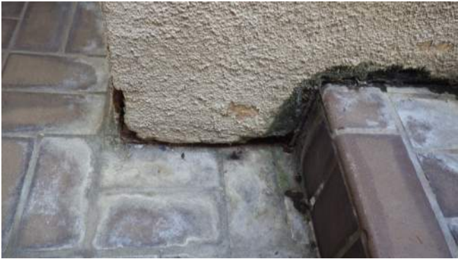
OPC exterior stairs
