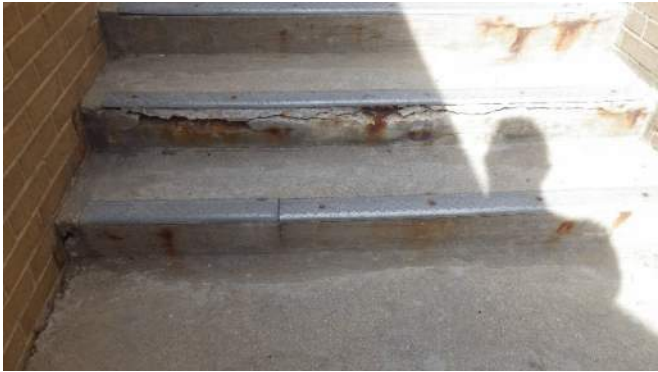
OPC exterior stairs
